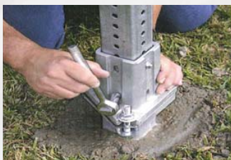
Postes Colapsíveis, e Perfis C
